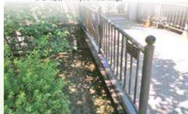
PatInaLock塗布後の備前島橋（中京区）
