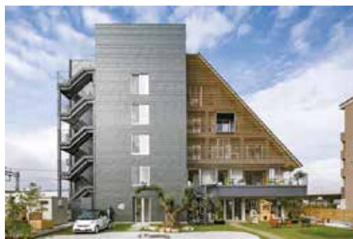
大型木造建築の 本社ビル 「SU・BA・CO」
