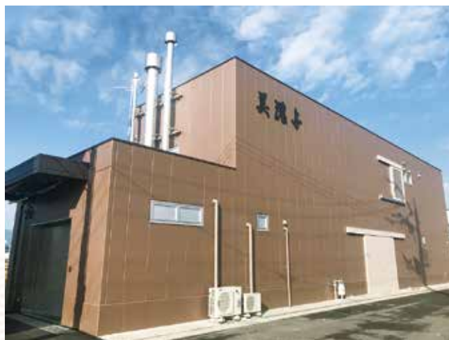
2018(平成30)年12月に竣工した京都市伏見区のきな粉専用工場
