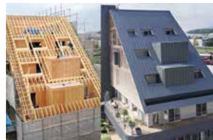
左：建設中 右：完成
