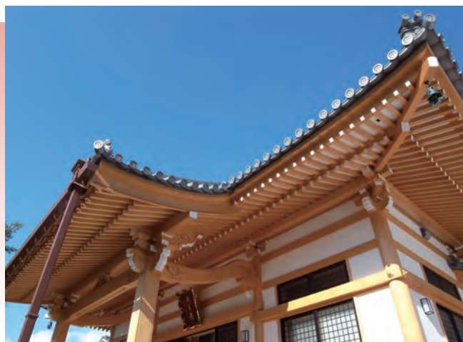
施工事例：西安寺本堂（2012（平成24）年竣工、兵庫県西宮市）
