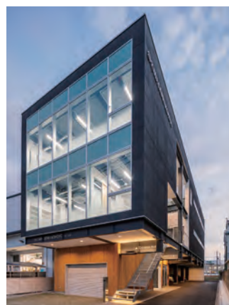
新社屋のエントランスには、全国的にほとんど導入事例がない、環境に優しい廃材を用いた新しい建材を使用
