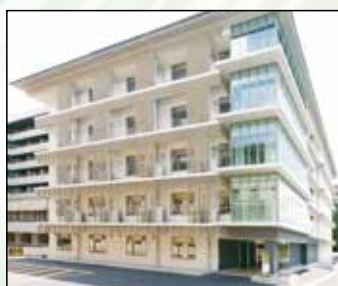
京都市ライフイノベーション 創出支援センター 京都大学医学部附属病院 先端医療機器開発・臨床研究 センター5階 507号室
