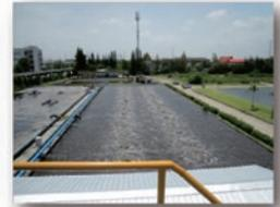
タイアマタナコン工業団地集合排水処理 ラグーンポンドの表面曝気から エアレータS1に入替処理能力向上 電気代大幅削減 65kw⇒30kw 55%の省エネ
