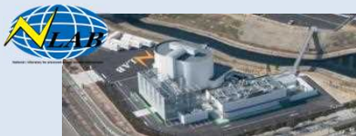
大型蓄電池システム試験・評価施設(大阪)
